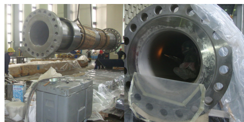
Abrasives Trockeneisstrahlen in einem Stahlrohr
